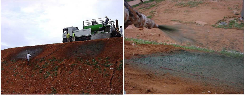
Figura 4.11. Aplicación de una mezcla de semillas mediante hidrosiembra mecanizada en un talud de carretera en la autovía A3 (Requena, Valencia). Fotos: E. Bochet.
