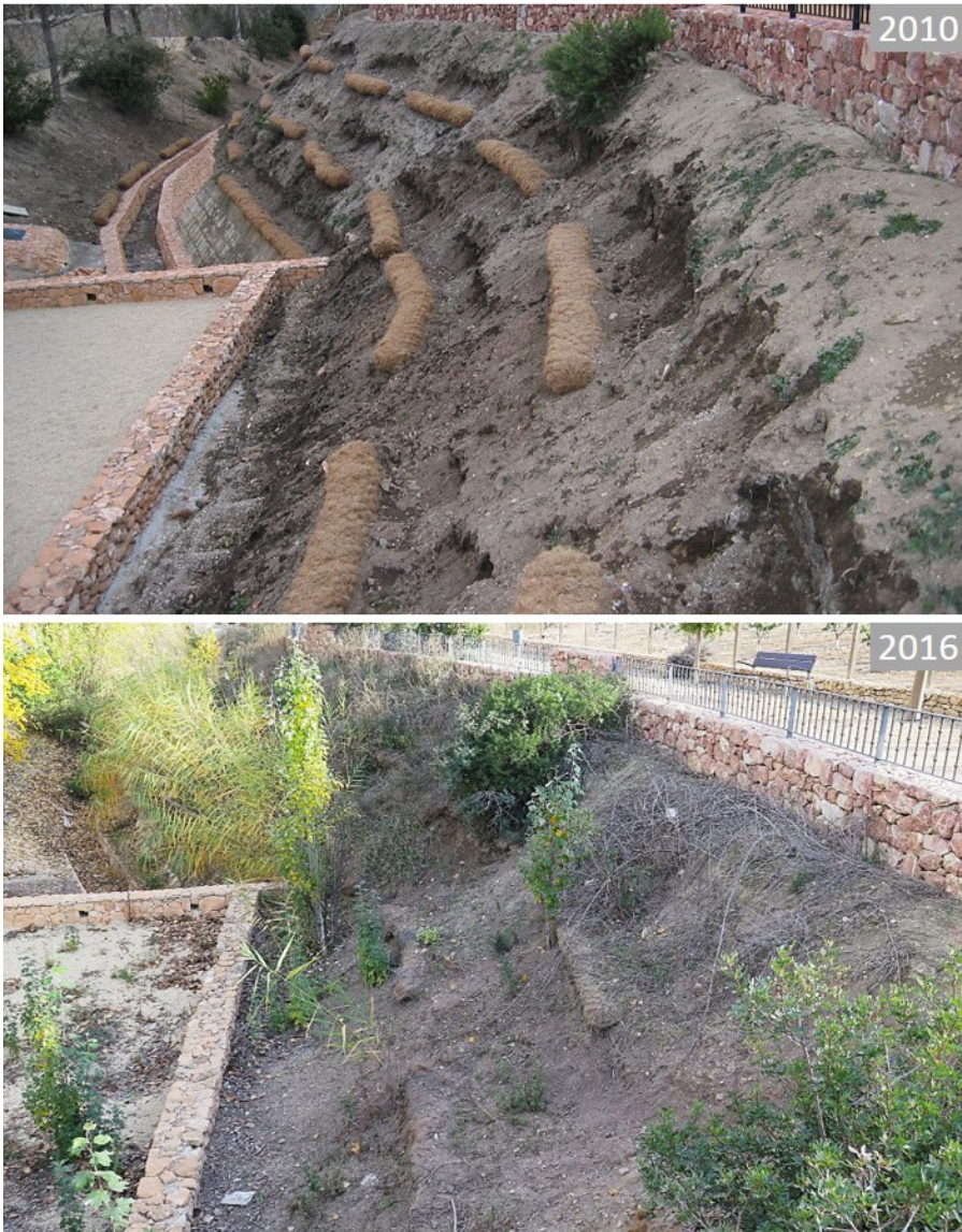
Figura 4.14. Estabilización de un talud ripario periurbano en Bullas (Murcia) mediante la utilización de biorrollos de fibra vegetal de 40 cm de diámetro y 3 m de largo. La actuación llevada a cabo por la Confederación hidrográfica del Segura en 2009 incluyó la plantación de especies leñosas en banquetas sobre los biorrollos. Dado el escaso desarrollo de la vegetación en parte del talud, sería recomendable una corrección mediante el uso combinado de plantación manual en banquetas de especies como Salix purpurea , Rosa micrantha o Crataegus monogyna , e hidrosiembra en talud de herbáceas como Brachypodium phoenicoides , Trachelium caeruleum y Ranunculus arvensis .
