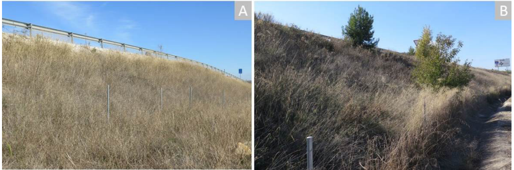
Figura 2.9. Taludes de carretera en la autovía RM-15 a su paso por Bullas. La vegetación Ruderal ha colonizado de modo natural tanto el talud de orientación Sur (predominio de Piptatherum miliaceum con Plantago albicans ) como el talud Norte ( Piptatherum miliaceum con Dittrichia viscosa ) 15 años después de su construcción.
