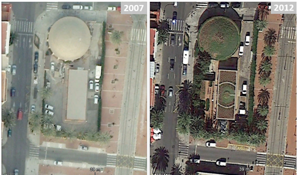
Figura 3.5. Uno de los escasos ejemplos de tejados verdes en la ciudad de Valencia, en el barrio del Cabañal. Situación antecedente y tres años después de las obras (Fte: Google Earth).
