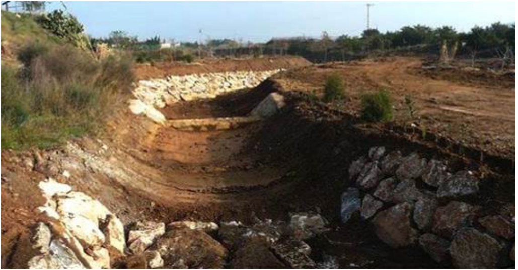
Figura 4.4. Trabajos de estabilización de taludes mediante construcción de muros y escolleras con bloques de caliza en la Rambla de Las Matildes (T.M. Cartagena, Murcia). Foto: Fundación Sierra Minera.
